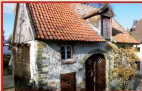
Deelentor in der Traufwand, darüber ein Kranhäuschen
