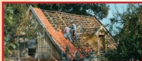
Neubau des Daches
